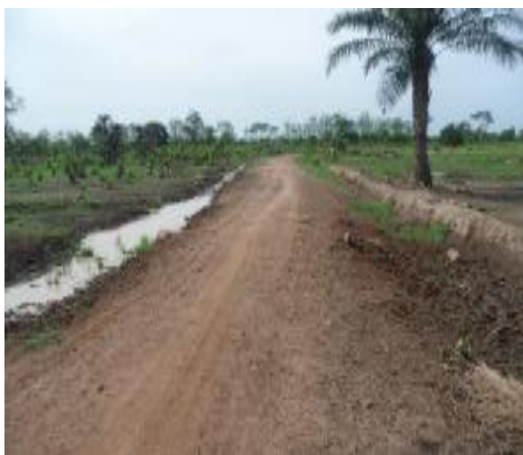
Comblement de fossés maçonnés
