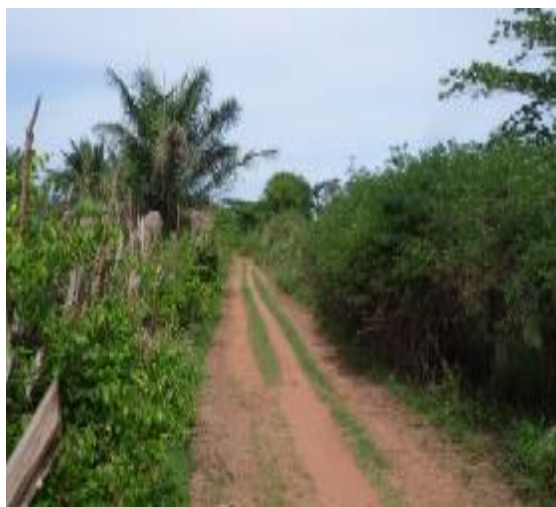
Végétation abondante aux abords de la chaussée
